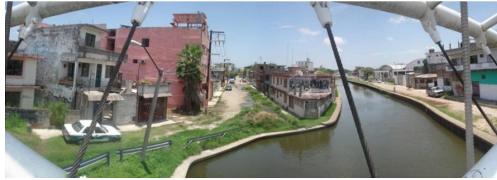
Foto 2. Estado de las viviendas en el sitio.
