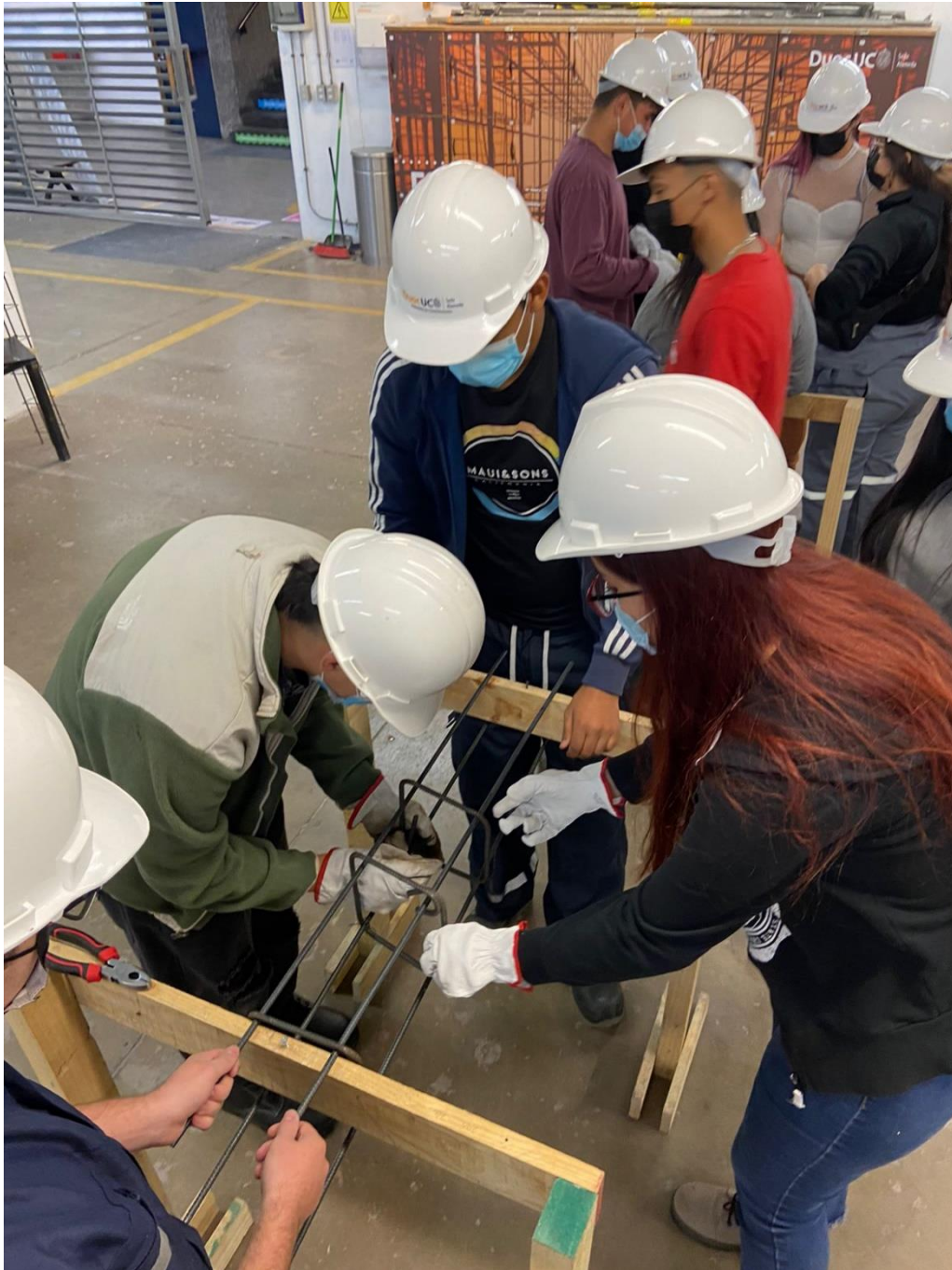
Imagen de actividad de taller ( armadura )
