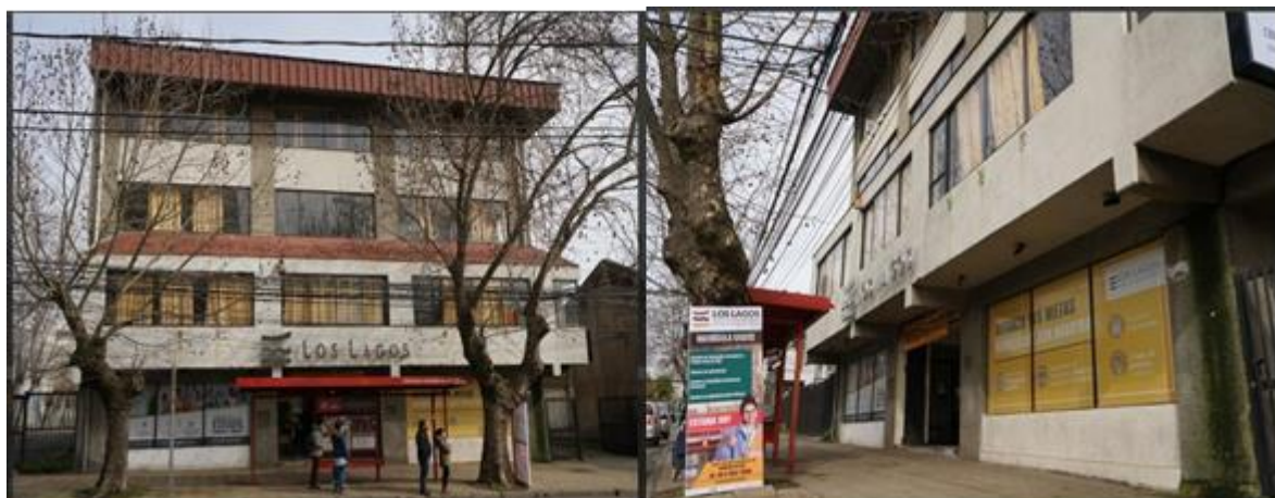
IP Y CFT LOS LAGOS SEDE LOS ANGELES
