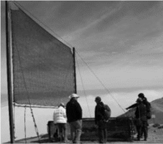
Atrapaniebla en el norte de Chile; esta herramienta captura las diminutas y escasas gotas de agua del ambiente. Pontificia Universidad Católica de Chile.
