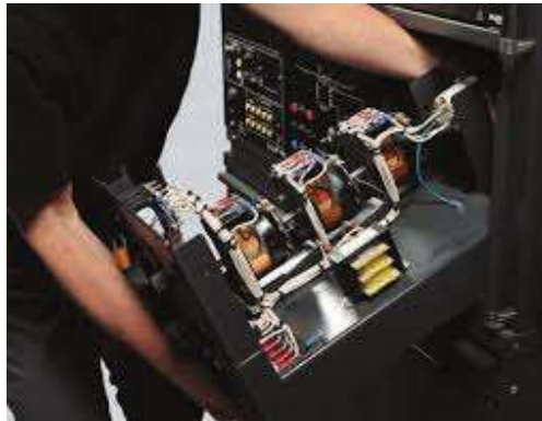
Extracción de modulo
